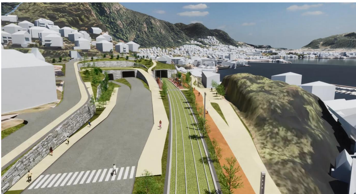
Figur 6-28: Holdeplassen ved Sandviken sykehus, sett fra nord. Hovedsykkelruten ligger vest for holdeplassen, mens tunnelportaler mot Fløyfjelltunnelen og Glass Knag ligger øst for banetunnelen. Ny gangforbindelse over E39 ligger over portalene.
